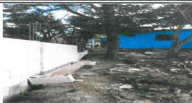
Foto 2: levantado de muro perimetral
