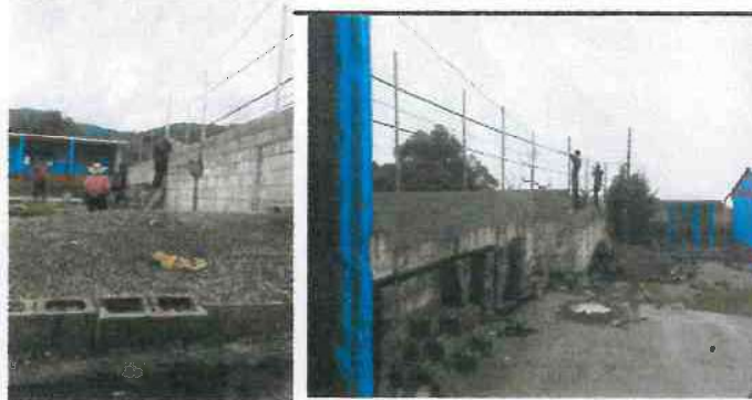
Foto 4: Reparación de muro perimetral y colocación de tubos y malla
