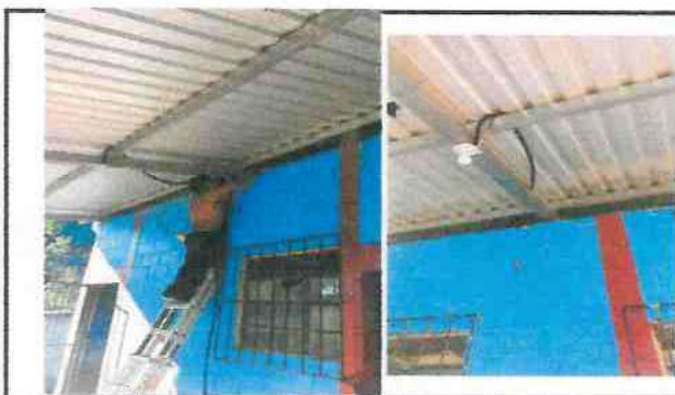
Foto 5: Reparación del cableado eléctrico
